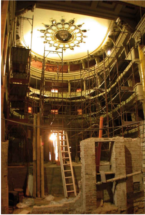
Lavori nella sala
