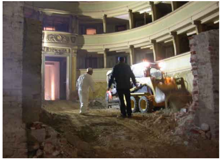
I primi lavori di ristrutturazione
